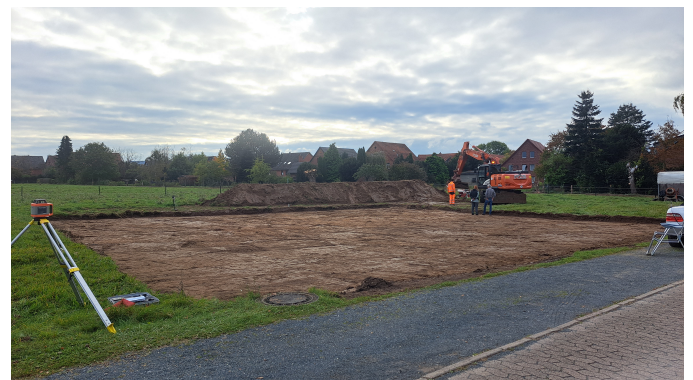
Abb. 3: Scheie, FStNr. 15. Blick auf das abgeschlossene Baggerplanum der Untersuchungsfläche.
