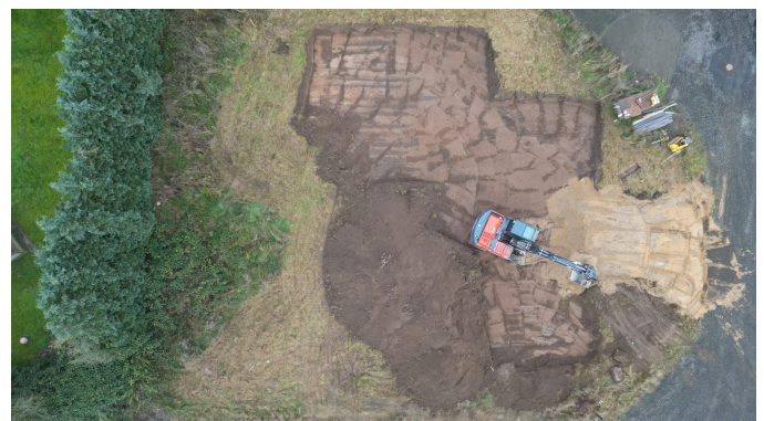
Abb. 7: Rohrsen, FStNr. 52. Erdarbeiten für ein Mehrfamilienhaus. Foto: H. Beneke.
